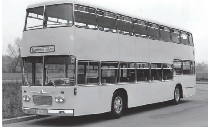
Konrad Auwärter konstruierte mit 27 als Diplomarbeit den so genannten Do-Bus, einen Leichtbau-Doppeldecker mit 4 m Höhe für die Linie, der ohne Sondergenehmigung auskam.
